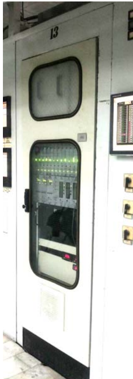
شکل ۶: تابلو مانیتورینگ در اتاق فرمان در حال بهره برداری
