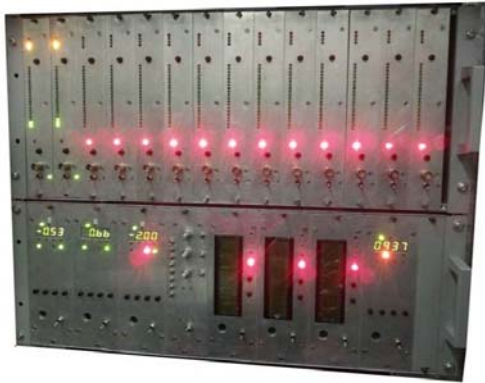
شکل ۵: سابركه‌های حفاظت و مانیتورینگ
