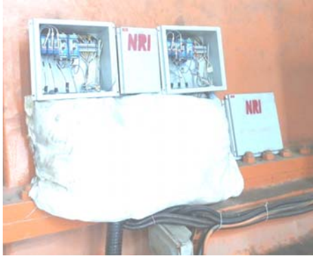
شکل ۴: نصب جانکشن باکسها با عایق حرارتی مناسب روی پوسته توربین
