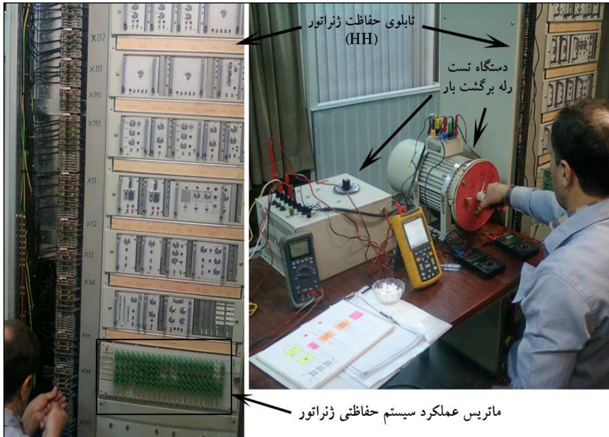
شکل ۱۲: بخشی از مراحل تست سیستم حفاظتی ژنراتور قبل از راه‌اندازی واحد
