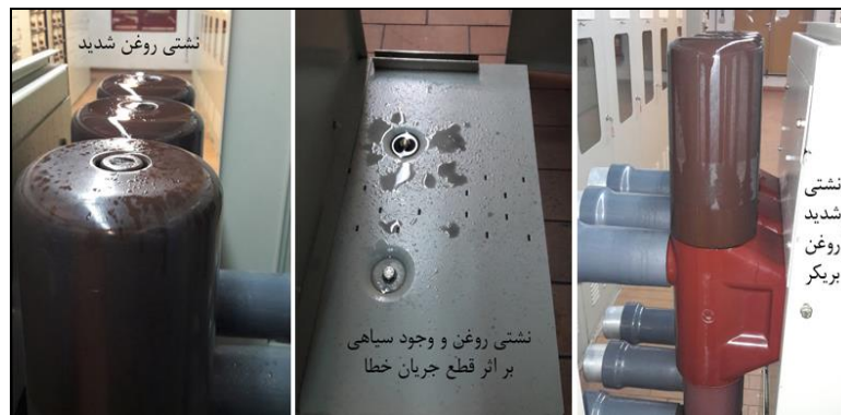
شکل ۵: قطع جریان شدید اتصال کوتاه و پاشش شدید روغن بریکر
