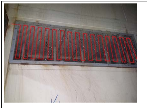
شکل ۶: موقعیت نصب کابل های حرارتی بر روی توری ها
