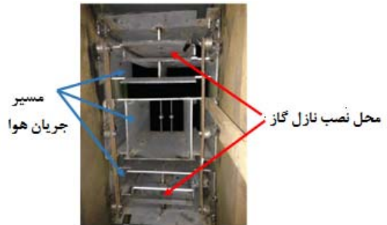
شکل ۱- ساختار و سیستم تیلت مشعل‌های گاز نیروگاه منتظر قائم [۳]
